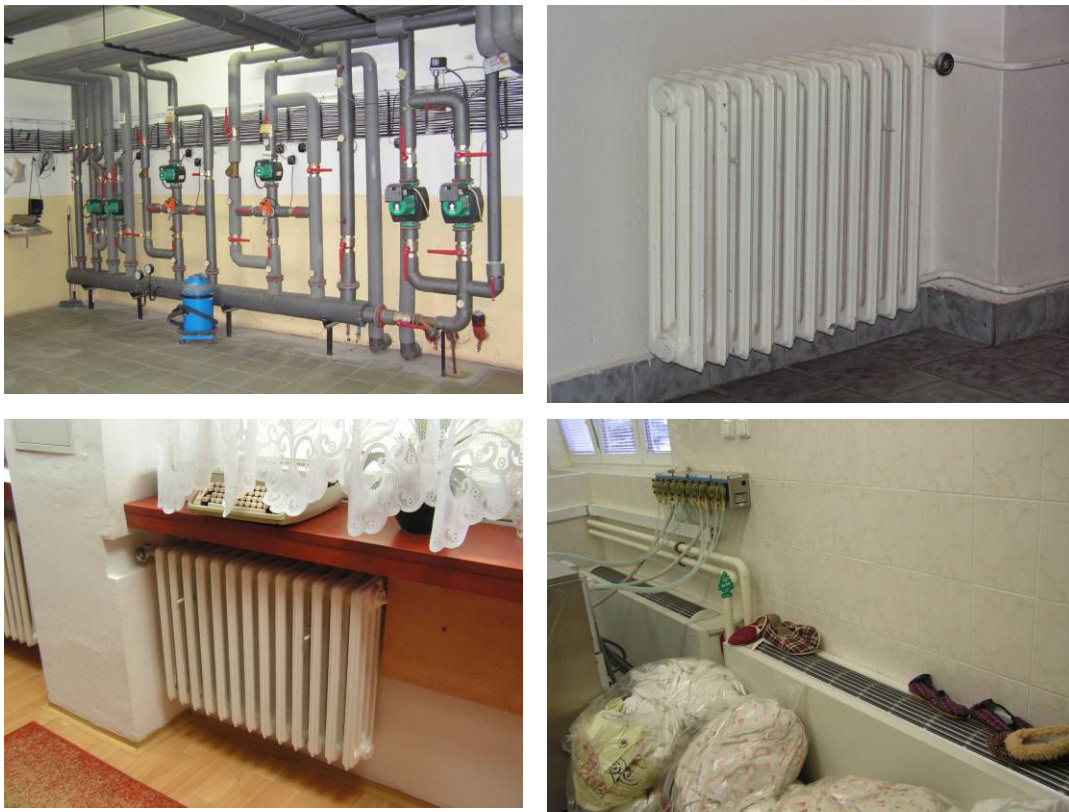
obrázek 5 Rozvody tepla, rozdělovač, otopná tělesa
